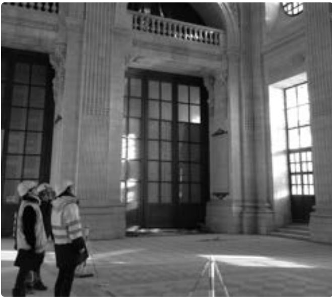
Visite de chantier - Hôtel-Dieu à Lyon
