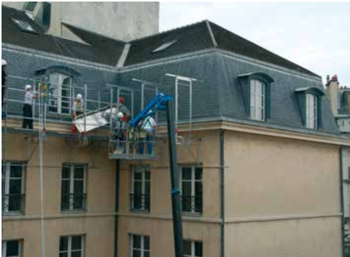
Fig. 26 – Pose de l'échafaudage à l'aide d'une PEMP
