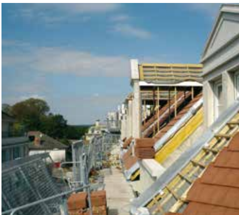
Fig. 16, 17 – PTE en protection de bas de pente pour travaux de couverture
