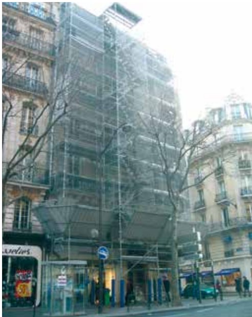
Fig. 9 – Échafaudage avec sapine d'accès servant pour le ravalement et les travaux de couverture
