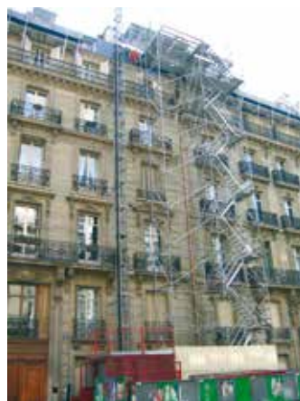
Fig. 34 Rack de stockage d'approvisionner le chantier en toiture, pour les éléments d'échafaudage complété par une tour escalier
