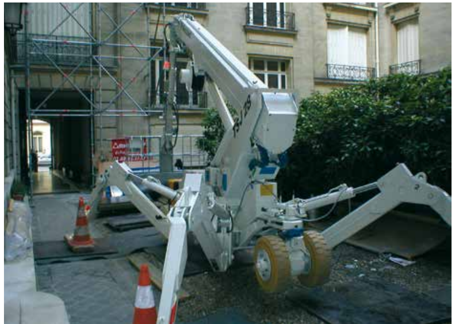
Fig. 24 – PEMP installée dans une courette
