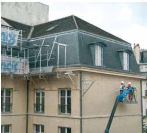
Fig. 19, 20 – Consoles métalliques mises en place à l'aide d'une PEMP
