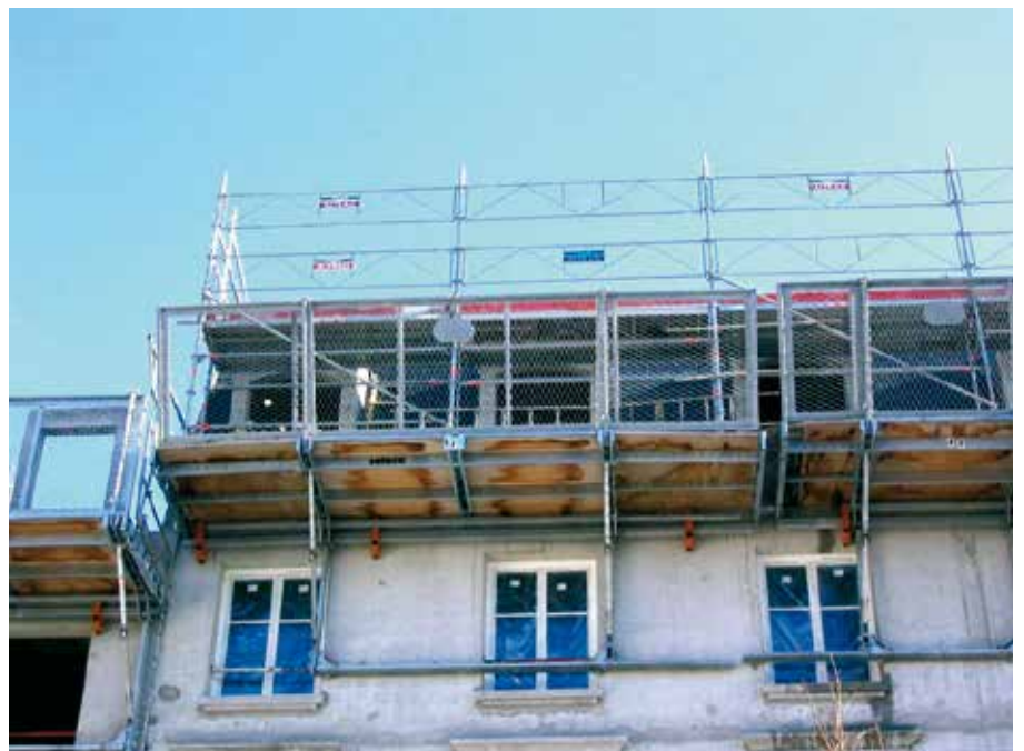
Fig. 18 – Plancher de travail - protection bas de pente – sur échafaudage reposant sur les PTE du gros œuvre conservées en place
