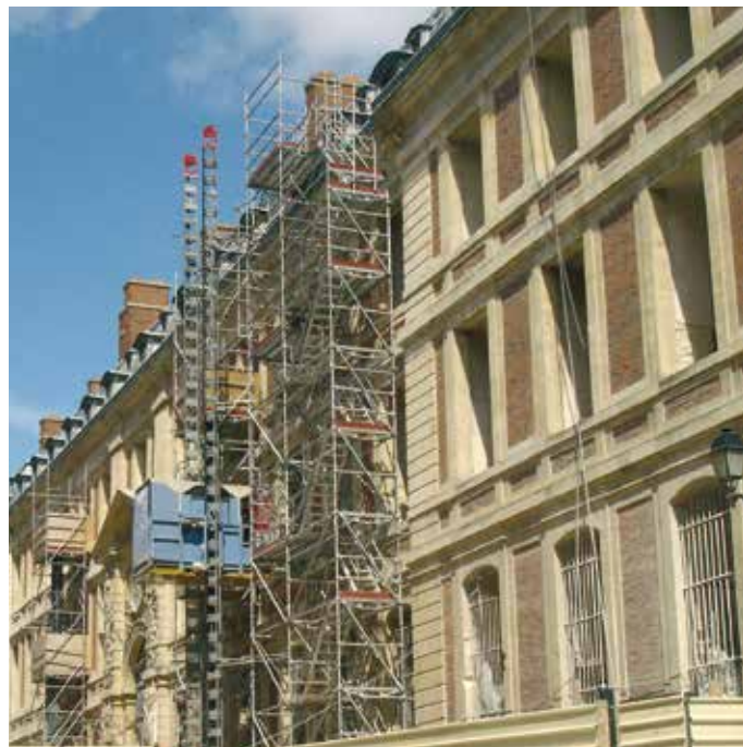
Fig. 32 Monte-matériaux en façade
