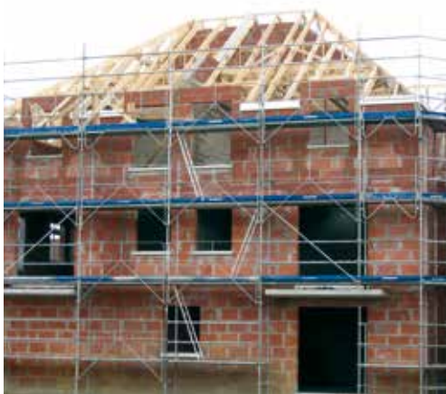
Fig. 8 Échafaudage MDS servant les travaux de ravalement, de charpente et de couverture*
