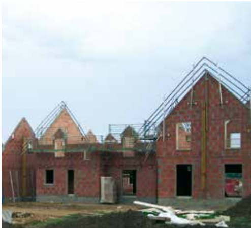
Fig. 6 – Garde-corps en rive de toiture
