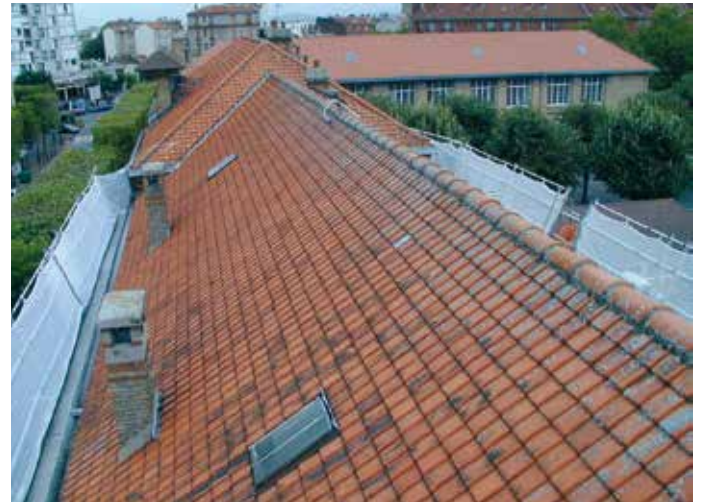
Fig 28 Protections bas de pente vues du toit
