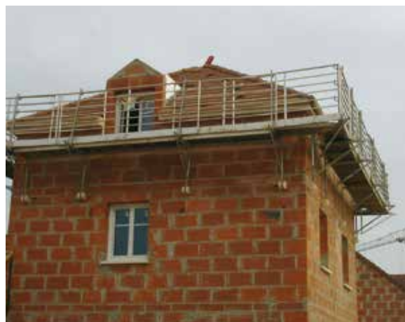
Fig. 21 – Échafaudage sur consoles assemblé et mis en place à partir du sol
