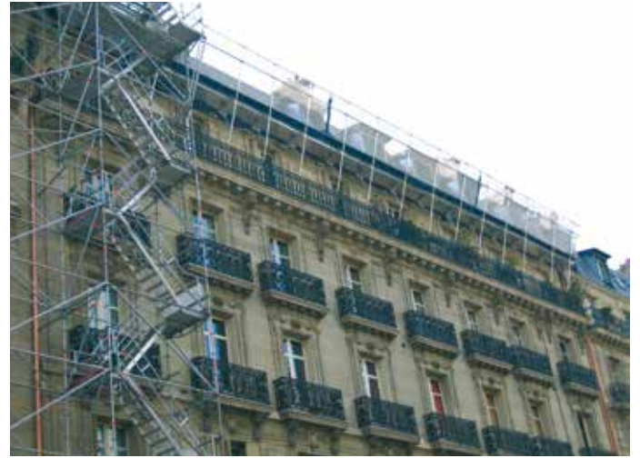
Fig 27 – Échafaudage sur consoles métalliques
