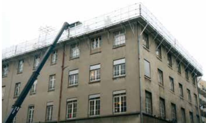
Fig. 38 – Opération d’approvisionnement d’un chantier
