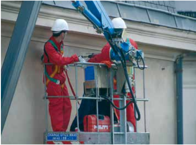
Fig. 25 – Pose des ancrages pour les consoles
