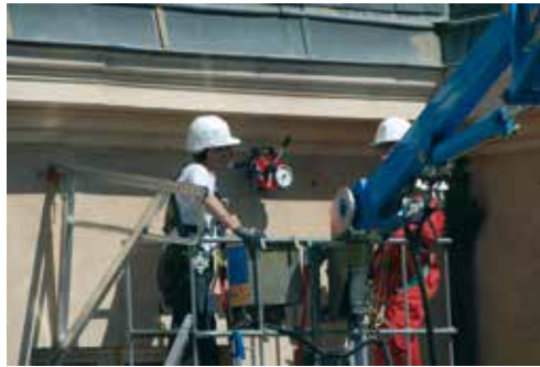
Fig. 2 – Contrôle de la résistance des ancrages sur chantier
