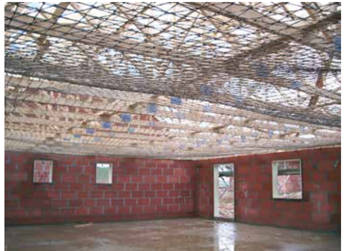
Fig 31 Filets en sous-face de la charpente
