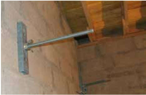
Fig. 1 – Ancrages traversants d'une console d'échafaudage
