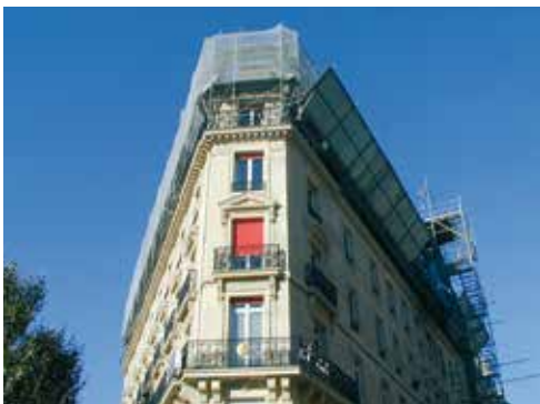
Fig. 12 – Plancher de travail – protection bas de pente – sur échafaudage multidirectionnel prenant appui sur balcons, avec pare-gravats, monte-matériaux et tour d'accès
